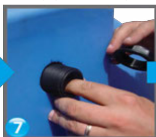
7 Se montează kitul niplu-piuliță: se așează una dintre garnituri FE pe niplu, apoi niplu se va introduce în gaura executată dinspre interiorul rezervorului, după care se așează și cea de-a 2-a garnitură FE pe filetul niplului și piulița, care se va strânge ușor.
