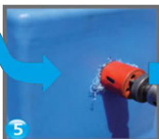
5 Se găurește cu freză pentru lemn sau plastic drilling/ просверливание
