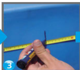
3 Se trasează centrul găurii marking the center of the hole/ центрирование отверстия
