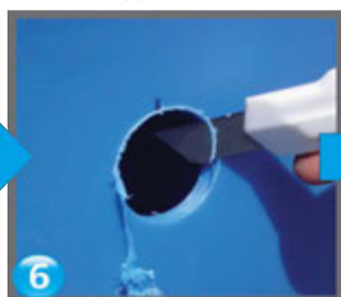
6 Se debavurează gaura finishing the hole/ обрезка
