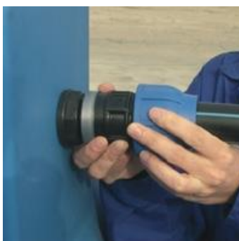
Montarea corpului racordului de compresie
